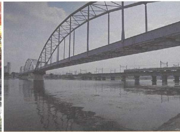
大正元（1912）年に札の辻～三条大橋間で開業した京津線。大正10年8月にJR東海道線の線路移設に伴い、上関寺付近に設けられた跨線橋。JRでの施設名は上関寺トンネルだが、京津線ではJR東海道線蟻丸跨線橋となっているのが興味深い。橋が掛けられた当時は、煉瓦造りだったが、線路増設に伴う架橋ではコンクリートとなっている。蟻丸跨線橋は、今日に至る鉄道構造物の変遷を伝えている。
